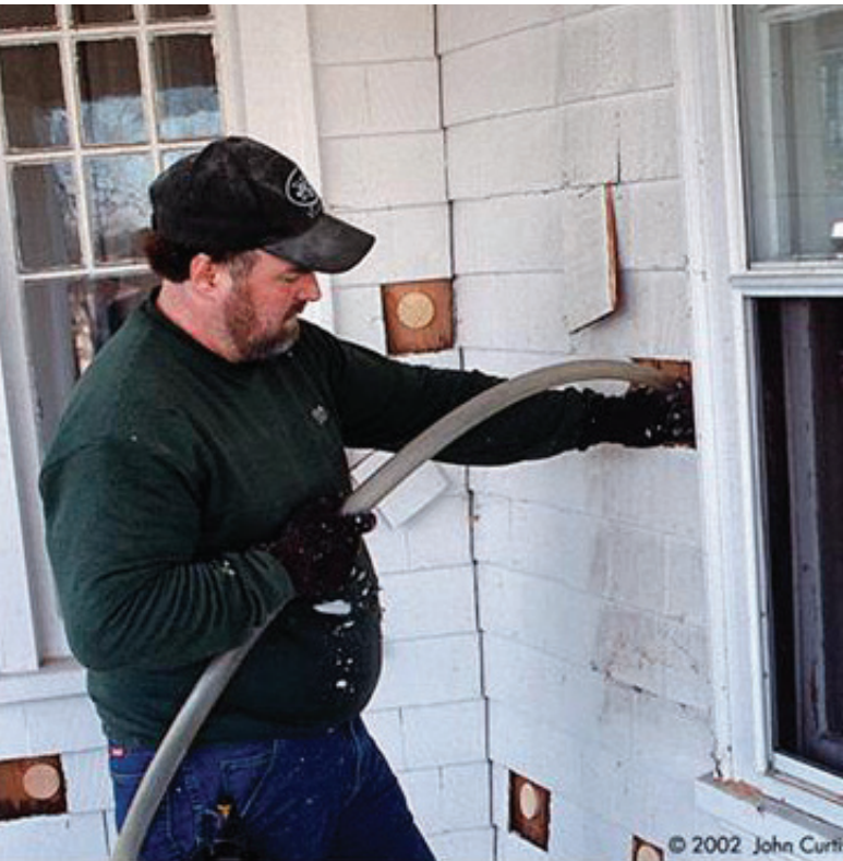
Exterior wall fill tube
